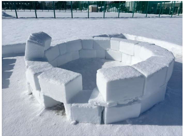
写真2 イグルーの土台作り。雪のブロックを円形に積み上げてドーム状に構築して行くのです。昨年度は暖かい日にイグルーの天井が崩れ落ちてきましたが、今年度は天井の作製に一工夫入れています。
