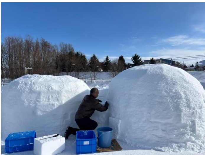
写真3 イグルー作製に黙々とはいげむ坂井先生。この写真はツインドーム様のイグルーのつなぎ目を構築しているところであり、ここを通路として人が移動できるようにして行く計画です。
